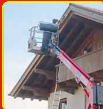
Holzianstrich mit Arbeitsbühne
