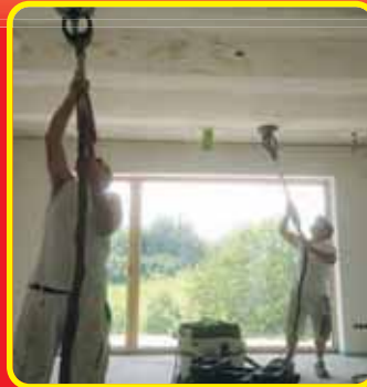
Fugenschleifen am Neubau
