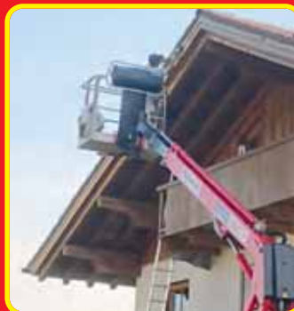
Holzianstrich mit Arbeitsbühne
