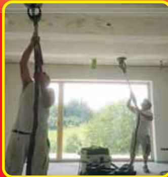
Fugenschleifen am Neubau
