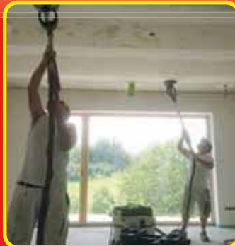
Fugenschleifen am Neubau
