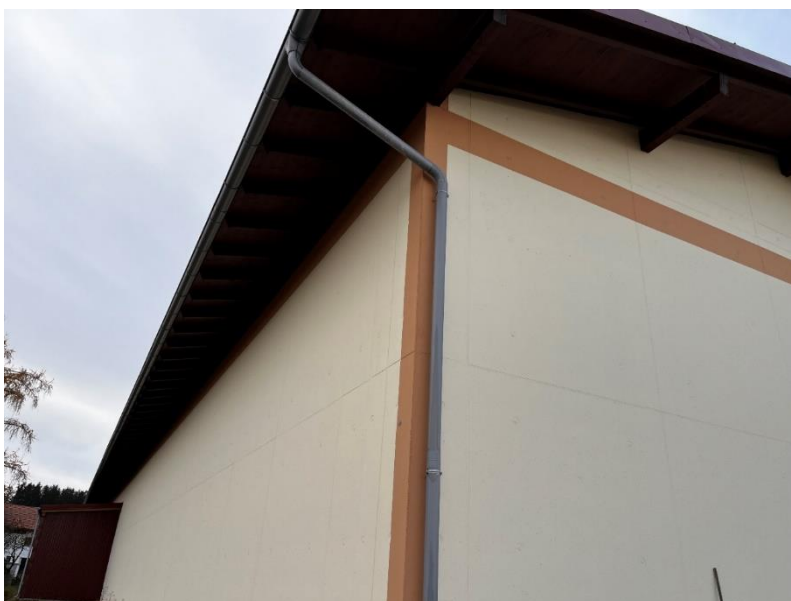
Dachüberstand bestehende Lagerhalle
