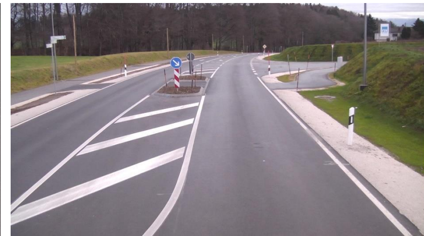
Zufahrt Gewerbegebiet Waltersham
